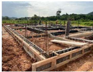
【写真左2枚：ガーナ・アシャンティ州マンソ・ヌクワンタの学校建設現場】
