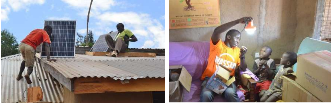
【写真左上 : ケニアのサウリ村にて行われた設置作業、右上 : 電気を見て喜ぶ子ども達】
