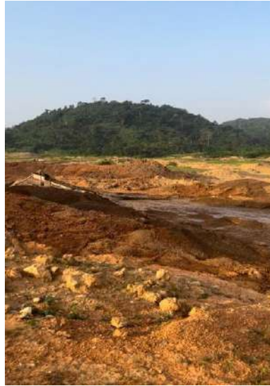
写真5：再度洗浄を行っている様子
